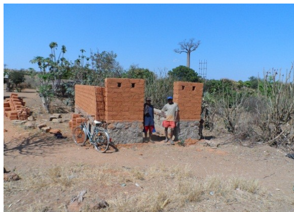
Mit dem Bau eines Stalls wurde begonnen
