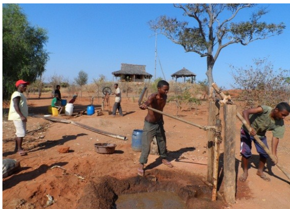
Ein neuer Brunnen wird gebohrt
